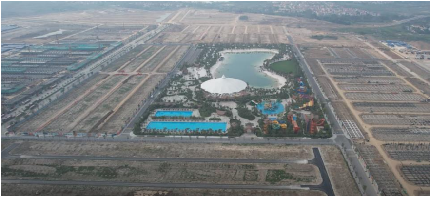
Hình 4. Dự án Vinhomes Ocean Park 3 – The Crown
